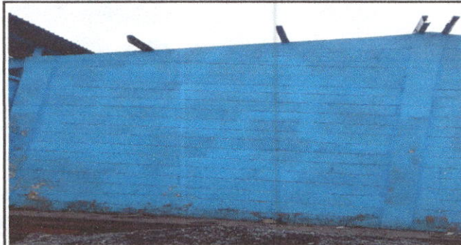
Foto 5: Sustitucion de sujecion de laminado
