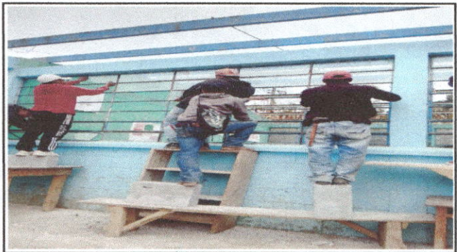
Foto 4: Sustitucion de vidrios
