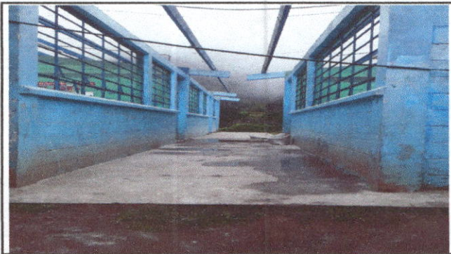
Foto 1: Sustitucion de porton
