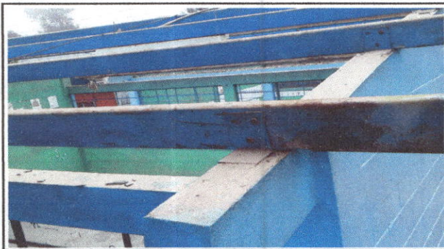
Foto 3: Sustitucion de canal
