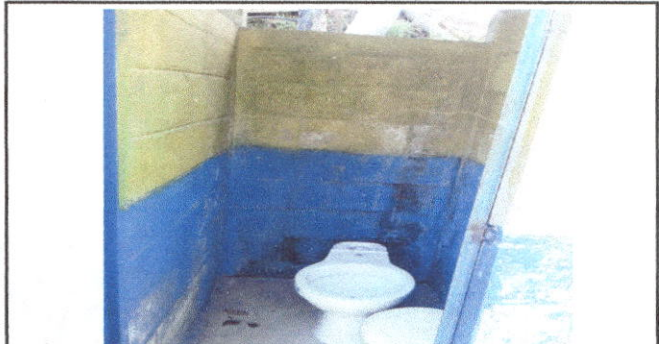
Foto 6: Sustitucion de Puerta de Baño.
